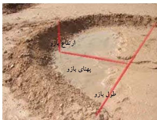
شکل ۲- نحوه اندازه گیری هلالی آبگیر
