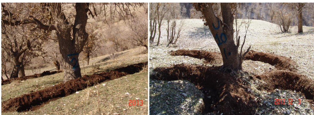
شکل ۲- نمای اجرا شده دو روش ذخیره نزولات فلسی (راست) و خطی (چپ)
